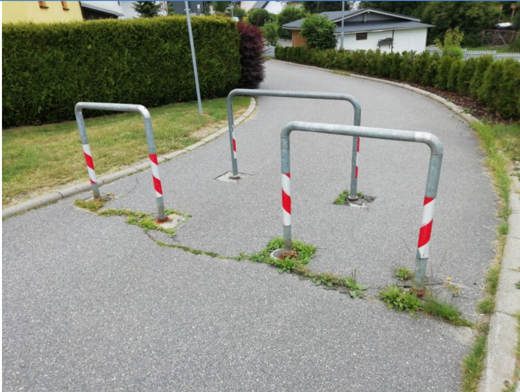
Hindernis im Bereich Dörfel (Stadtgebiet Marienberg, Ulrich-Rühlein-Straße/ Sonnenstraße)
