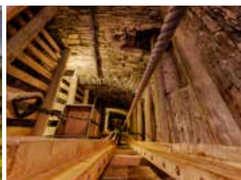
Blick in den Schacht
