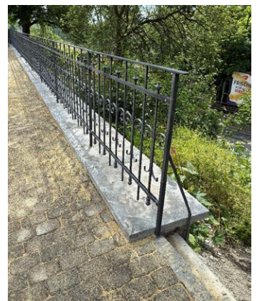
Instandgesetztes erstes Teilstück
