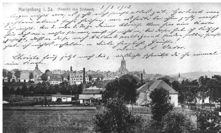
Marienberg, Ansicht von Südwest, gelaufen 1912
