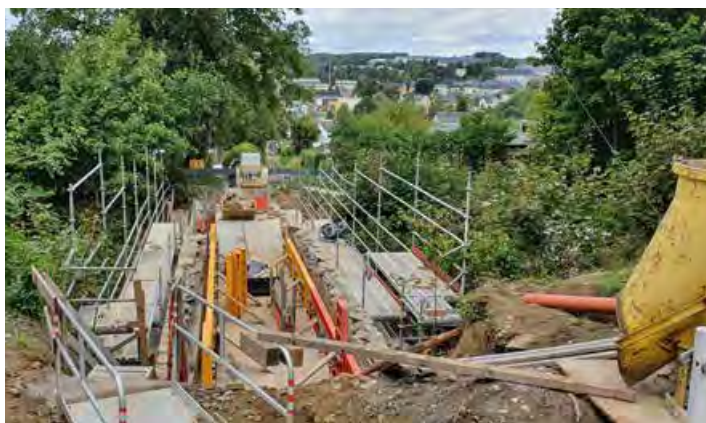
Steinbogenbrücke Görkauer Straße Ansicht von Alter Görkauer Straße in Richtung Stadteinwärts
