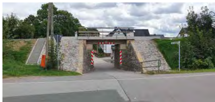
(fast) fertiggestellte Brücke Obere Gebirgsstraße
