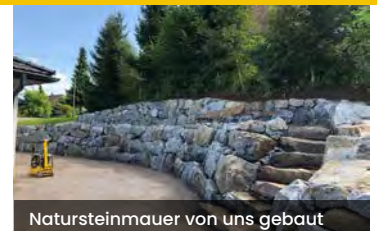
Natursteinmauer von uns gebaut
