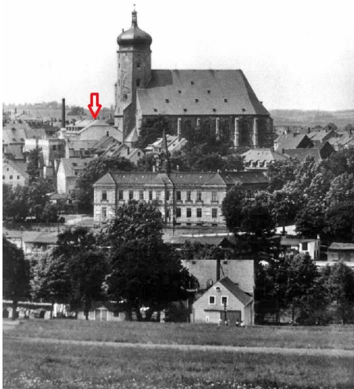
Bürgerschule bis 1893, Herzog-Heinrich-Straße 6, 1932
