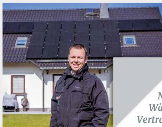
Eine PV-Anlage in Großbrückerswalde
