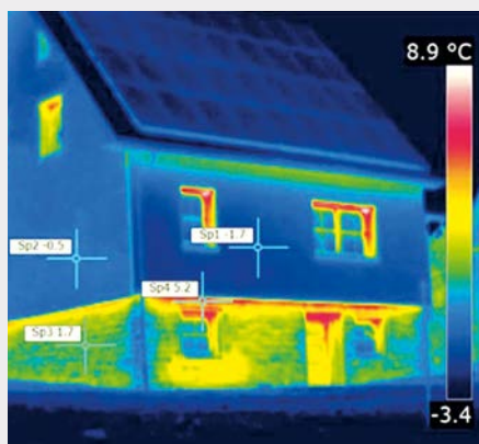
Thermografie zur Ortung von Wärmeverlusten Quelle: SEF-Energietechnik GmbH
